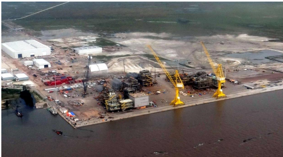
Figura 28 - O nível do estuário em outubro de 2015, alinhado ao cais do Estaleiro EBR, em construção à época.
