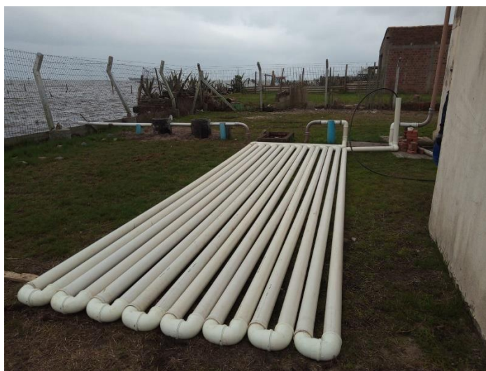
Figura 01 – Sistema de cloração por pastilha.
