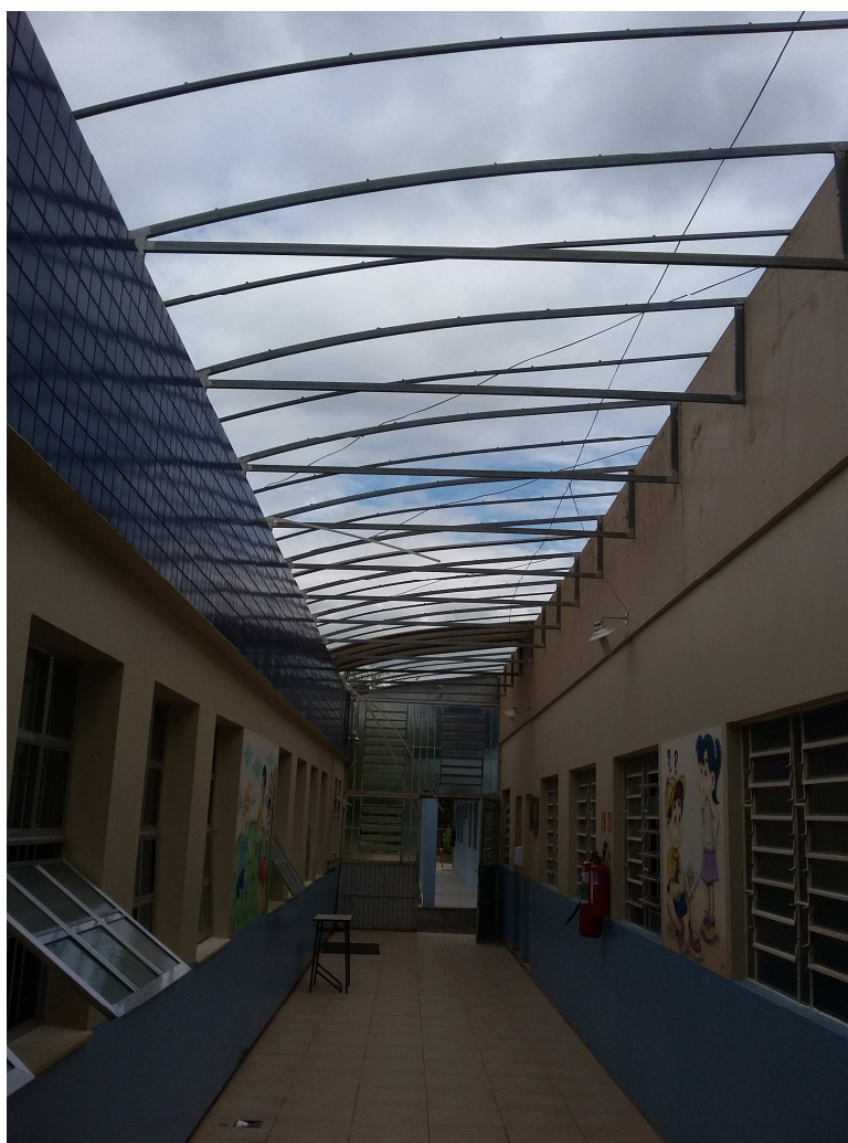
Imagem 01. Vista da cobertura que receberá o telhamento com policarbonato alveolar.
