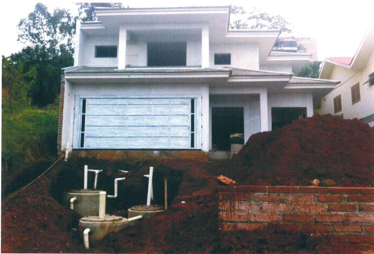
**Foto 17** - Vista de um sistema de fossa e filtro anaeróbio com extravasor para a rede pluvial.
