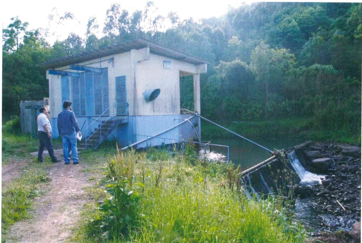
**Foto 10** - Sistema de captação e abdução junto ao Arroio Ackermann.
